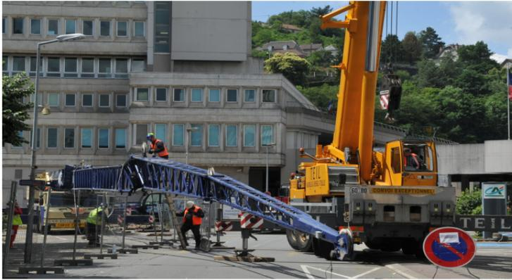
Réfection des toitures terrasses : installation d'une grue de 130 m pour approvisionner les chantiers situés au-dessus du 22<sup>ème</sup> étage
